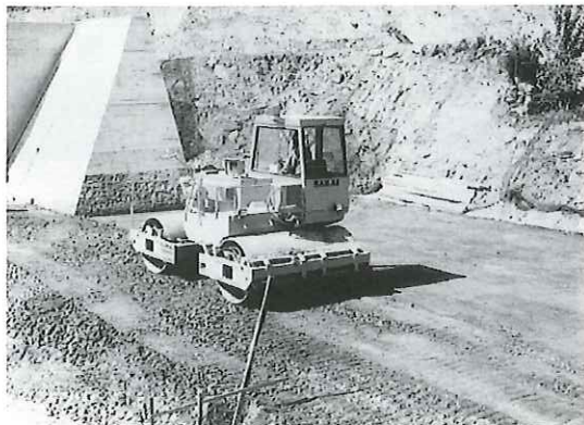
写真-6 振動ローラによる締固め作業
