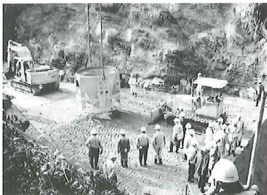
写真-5 ブルドーザによるまき出し作業
