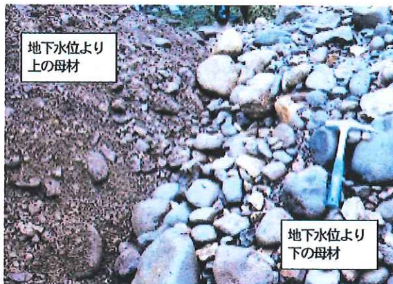
写真-1 河床砂礫を母材とした事例
