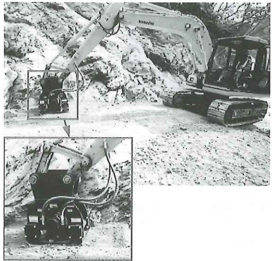
写真-9 振動機付きバックホウによる締固め作業
