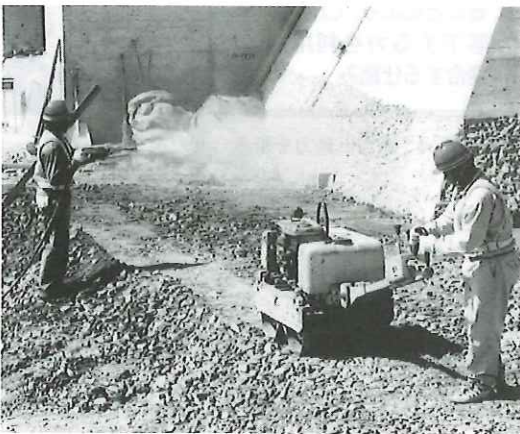
写真-8 小型の振動ローラによる締固め作業
