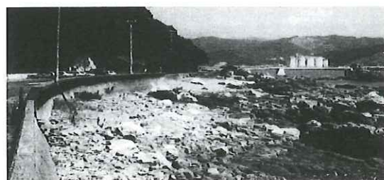
写真-2.2.1 遊歩道整備前
