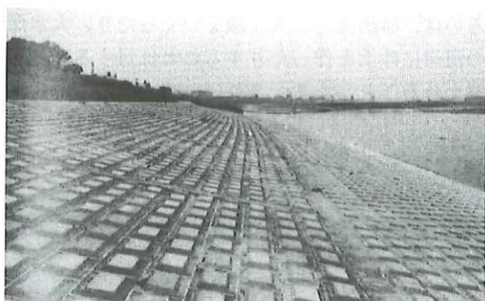
写真-2.4.2 大規模な緩傾斜護岸
