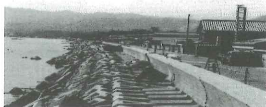
写真-2.4.1 直立護岸の整備
