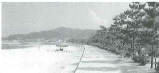
図-4 面的防護方式により整備された海岸
