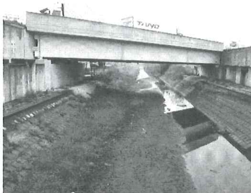
(a) 橋梁全景
