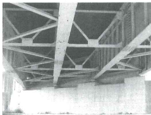
(b) 桁下の状況
