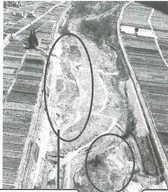
試験施工後 (平成18年3月)
