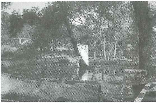
写真-4 引き倒し試験実施状況（荒川）
