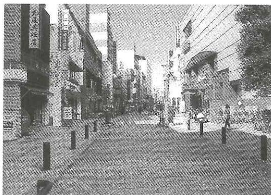
写真-3 生活道路整備後の状況
