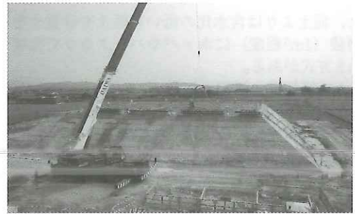
写真-8 軟弱地盤上の気泡混合盛土の打設状況
