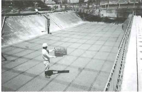
写真-7 気泡混合土の打設時の状況
