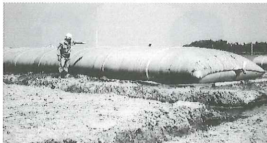
写真-3 袋詰脱水処理工法
