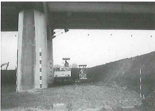
写真-5 既設橋脚周辺の嵩上げ盛土の現場状況
