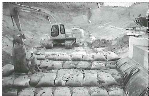
写真-10 溜池における袋詰脱水処理の現場施工状況
