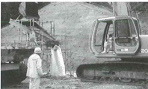
写真-9 袋への軟弱土の充填作業の状況
