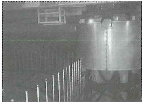
写真-3 みずみち棒が設置された汚泥掻寄せ機
