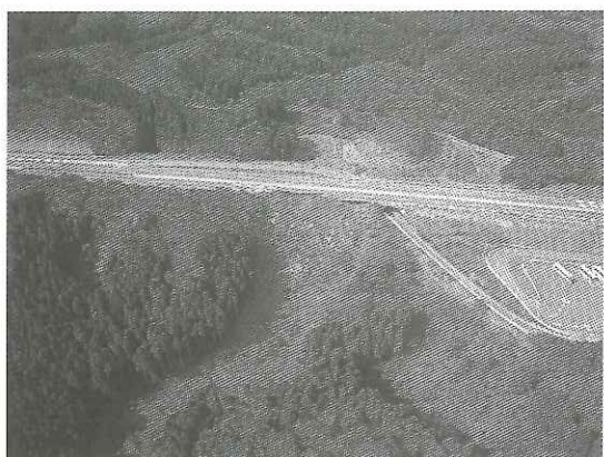
(b) 上空からの斜め写真 写真-3 能登有料道路の盛土崩壊
