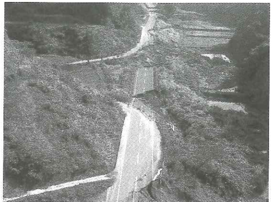
写真-1 一般県道大沢小国小千谷線の盛土崩壊 (新潟県提供)
