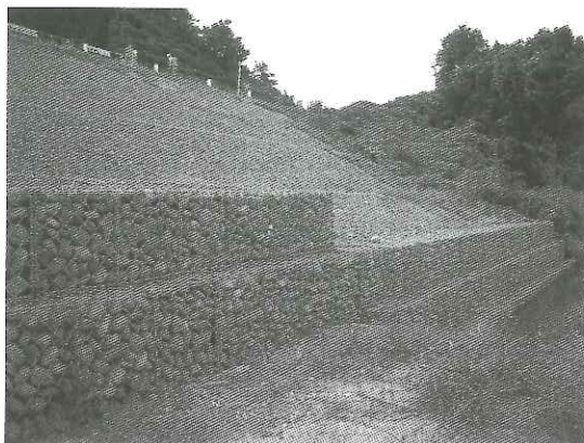
写真-4 のり先に大型ふとかごを設置してのり先の排水性を高めた事例
