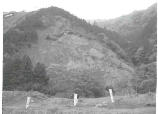
写真-1 地すべり地全景 (H18.5.14撮影)
