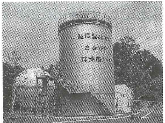
写真-3 メタン発酵槽
