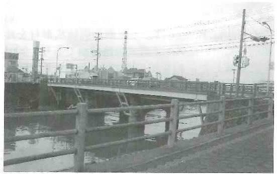
写真-4 鋼製の添架側道歩道橋
