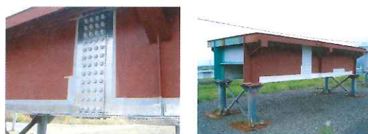
図-7 チタン箔シートの貼り付け作業状況
