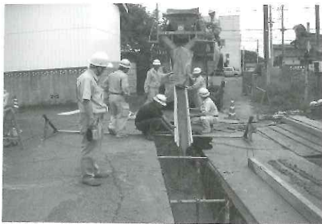
写真-2 流動化処理土の打設状況
