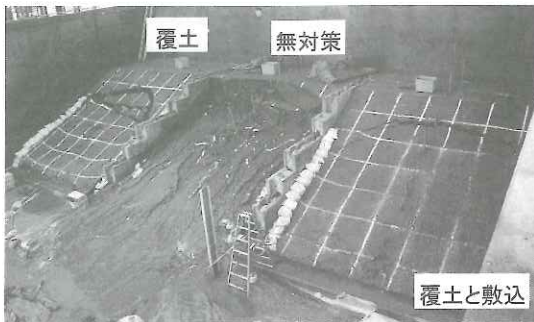
写真-2 短繊維混合被覆土工法の実験状況
