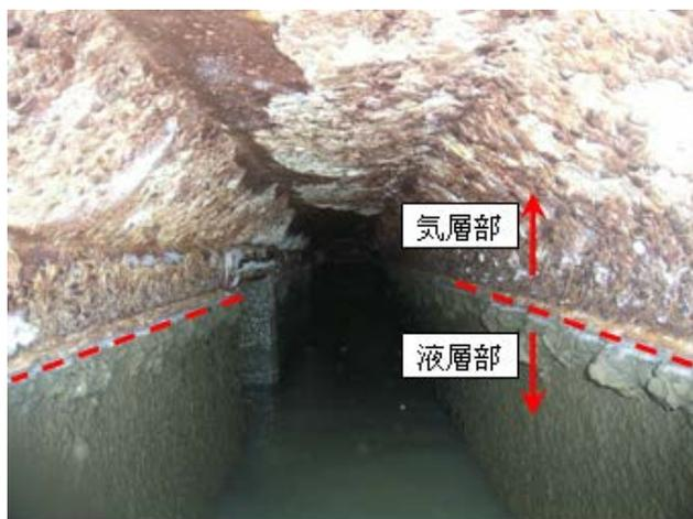
写真-1 処理場流入渠内のコンクリート壁面の腐食状況
