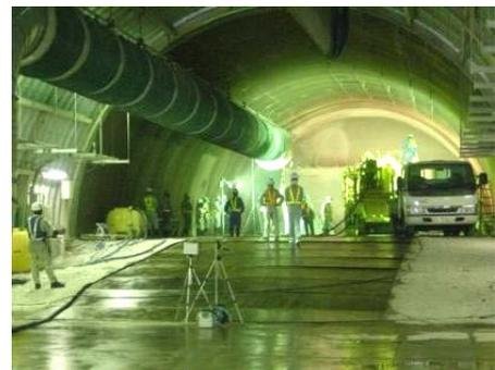
図-10 実験状況(伸縮風管システム)
