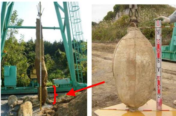
図-6 アンカーの出来形 (左: アンカー体、右: 耐荷体)
