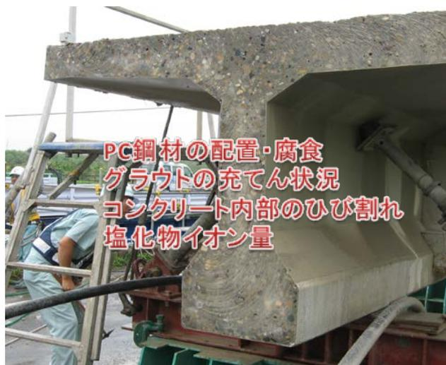
写真-2 桁の解剖調査
