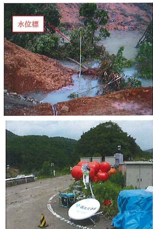
図-2 岩手・宮城内陸地震で発生した天然ダムにおける監視体制 (上:水位標、下:Ku-SAT)
