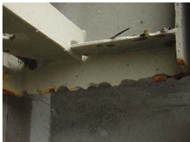
写真-1 縦端桁下部の腐食
