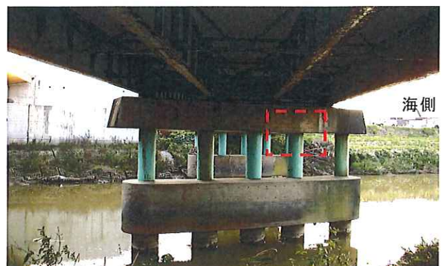
写真-4 撤去前のパイルベントの状況
