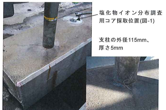
写真-1 調査対象の防護柵支柱(撤去直前)
