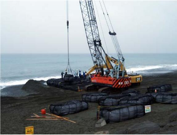
写真-3 試験体Cの現地据え付け
