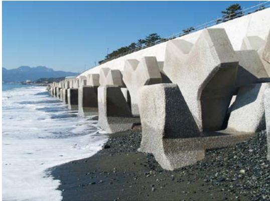
写真-6 摩耗量を調査したコンクリートブロック
