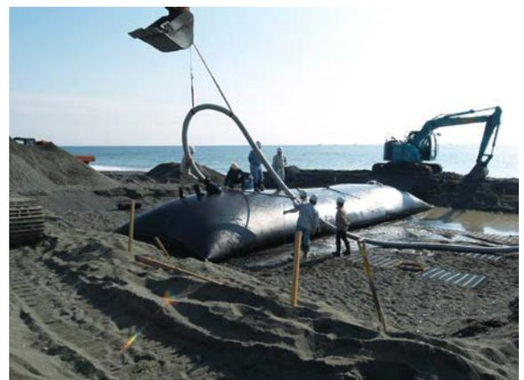
写真-2 サンドポンプによる試験体Bへの砂礫充填
