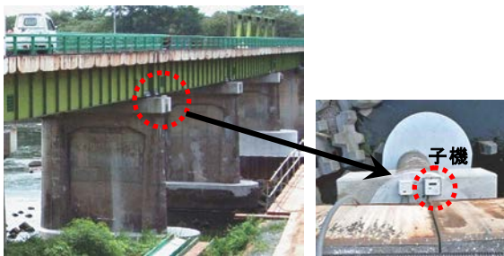
写真-5 被災後に応急対策が施された橋への適用例
