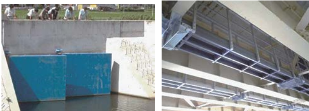
写真-1 最近のFRPの土木構造用途の例（左）FRP水門扉体、（右）FRP検査路
