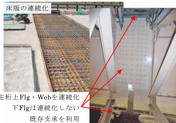
写真-4 連続桁化の施工
