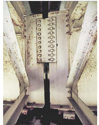
写真-1 耐震連結板構造
