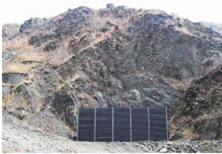
写真-3 仮設防護柵の設置状況
