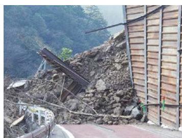
写真-1 幅30m、高さ35m、 崩壊土砂量1,100m 3 の崩壊により被災し た仮設防護柵
