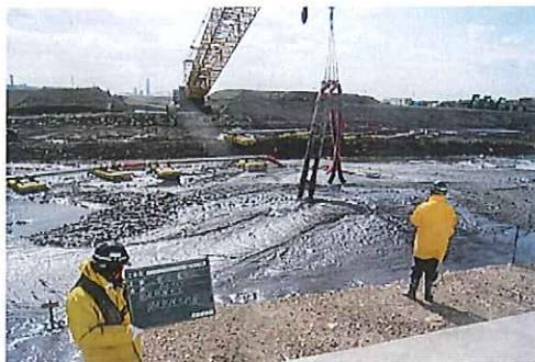
写真-3 トレミー管による打設
