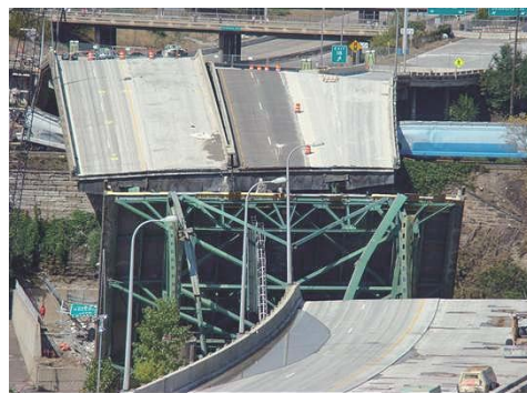
写真-1 崩壊した米国ミネアポリスI-35W橋
