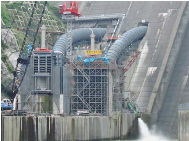
写真-1 五十里ダム増設放流設備据付状況
