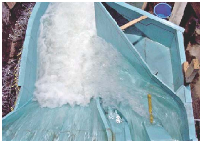
写真-3 長安ロダム導流部検討状況(上から見たところ)
