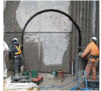
写真-5 堤体縁切作業
