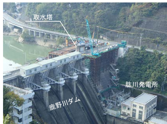
写真-2 鹿野川ダム選択取水設備 施工箇所（H25.11）
