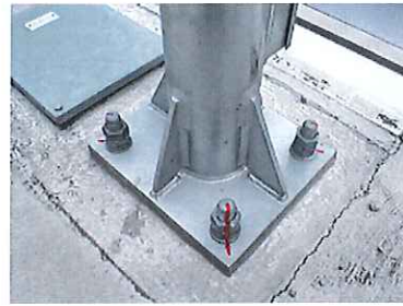
写真-1 合いマークの施工例
