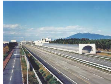
写真-1 実大トンネル実験施設
