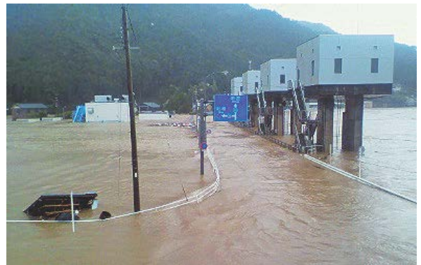
写真-1 氾濫した相野谷川と熊野川（鮎田地区）
