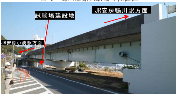
写真-1 試験場(坂下高架橋)の全景写真
