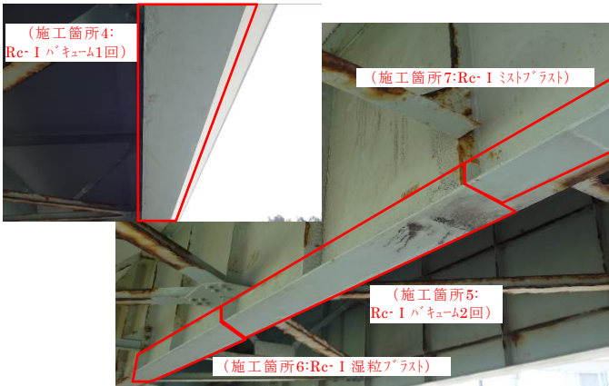
写真-7 H23年度試験施工結果 (施工後約2年経過時点) ている。
