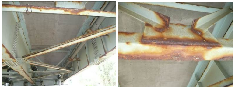
写真-5 坂下高架橋補修前の腐食発生状況
