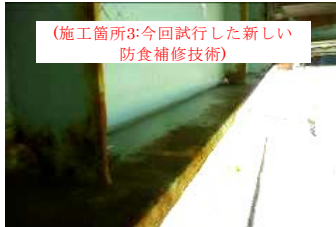
写真-6 H22年度試験施工結果比較 (施工後14ヶ月経過時点)
