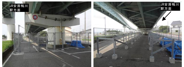
写真-2 試験場設備の全景
