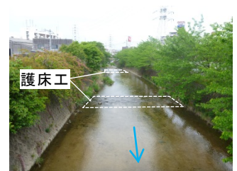
写真-1 上流区間の現況
