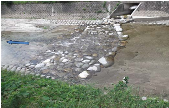
写真-2 完成した早瀬工
