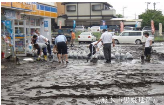
写真-1 平成24年7月12日出水後の状況 (熊本市黒髪地区)
