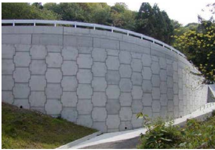
図-1 補強土壁の例(テールアルメ工法)
