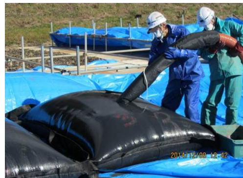
写真-4 充填の状況
