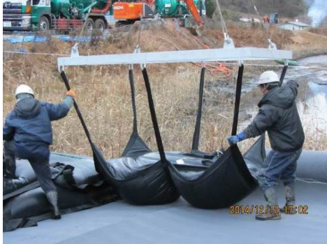
写真-5 移設状況
