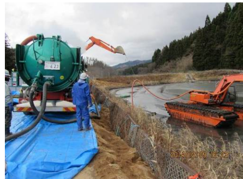
写真-3 バキューム車による吸引
