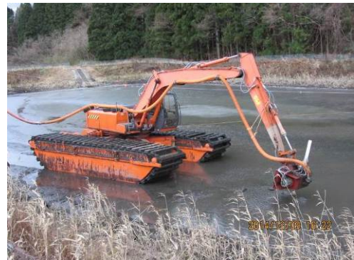
写真-2 泥上掘削機による掘削
