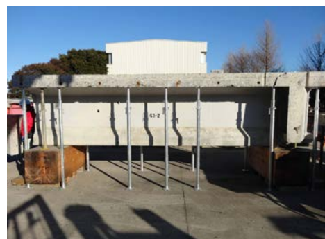
写真-9 3.95MeV機用撤去桁
