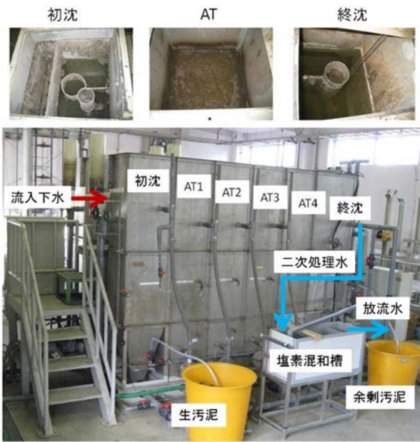
写真-1 活性汚泥処理実験装置
