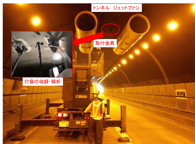
写真・2 ジェットファン取付アンカーの打音点検
