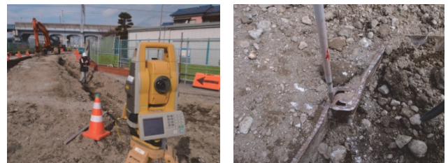
写真-1 土留工の現場
