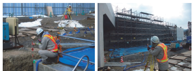
写真-2 擁壁工の現場
