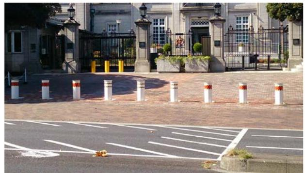
h.車両激突対応型ボラード（ライジングタイプ）
