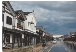
写真-1 都市計画道路における両側拡幅 牧之通り（南魚沼市）
