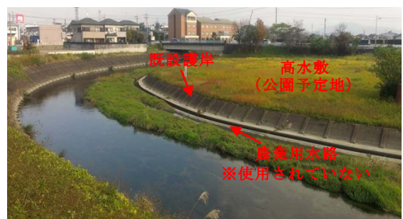
図-1 糸貫川の水際（施工前）
