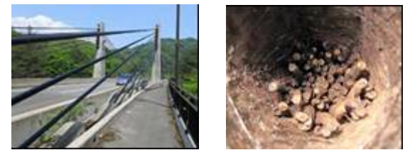
写真-6 腐食で破断した吊材の例
