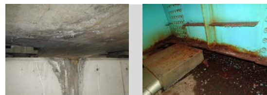
(a) PC橋の例 (b) 鋼橋の例 写真-2 作業空間確保が困難な例
