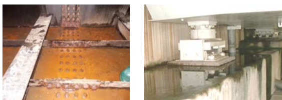
(a) 箱桁内滞水・腐食の例 (b) 橋座面の耐水の例 写真-4 耐久性阻害要因排除が求められる例
