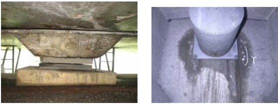
(a) 支承部レヤーの変状 (b) ケーブル定着部の変状 写真-7 内部の状態が認識しづらい例
