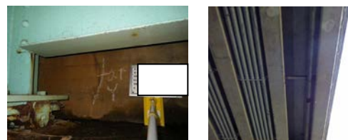
(a) 端横桁背面の例 (b) 添架物が支障となる例 写真-1 近接目視が困難な例
