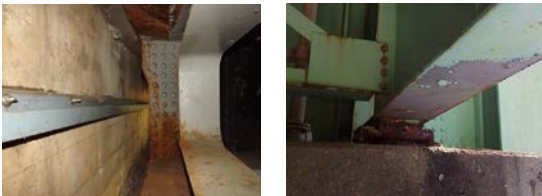
(a) 桁端部の腐食の例 (b) 伝い水の影響の例 写真-3 耐久性阻害要因防止が求められる例
