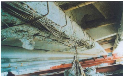
写真-1 塩害によって鉄筋やPC鋼材が腐食破断したコンクリート橋
