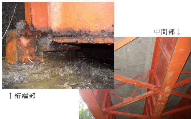
写真-1 T橋の桁端部と中間部外観
